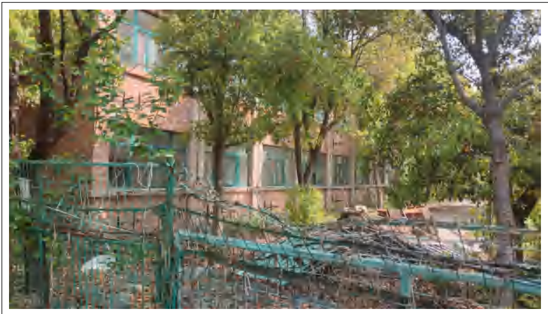
图 3.3-1 地块现状照片
