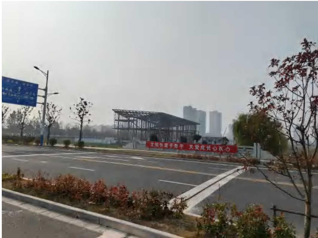
钢结构于2019年开工建设，已停工周边已围护。
