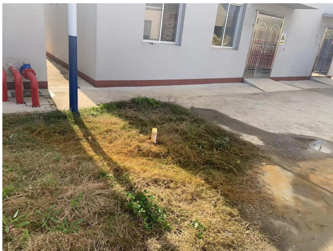
地下水监测井
