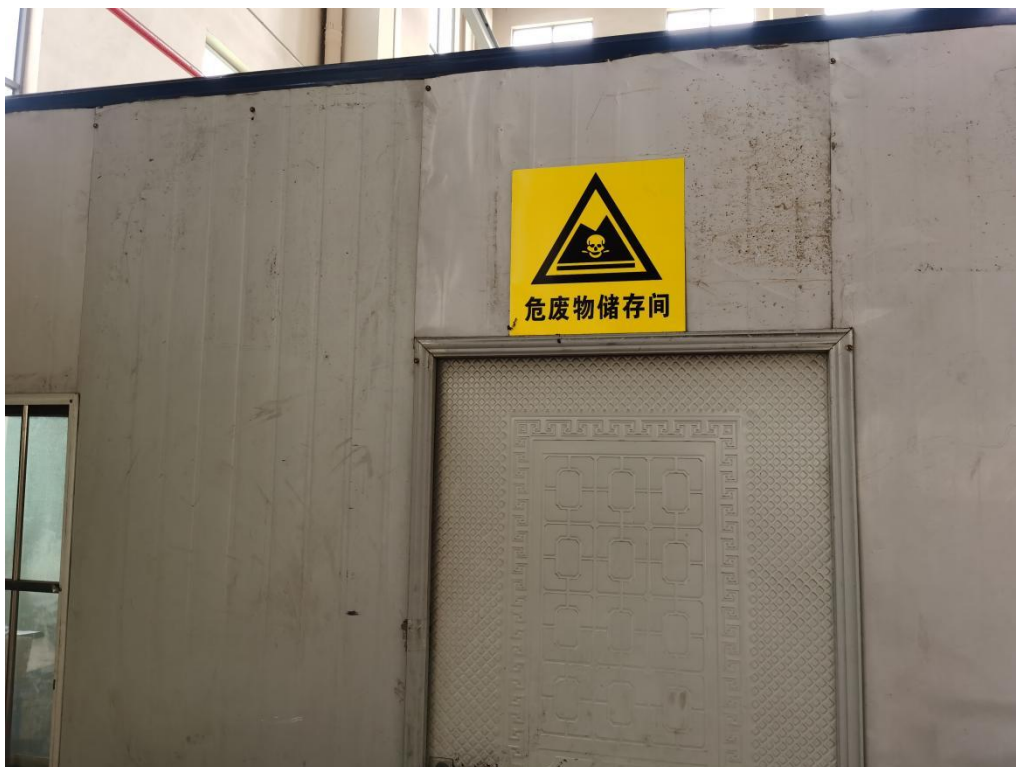
危废暂存场所
