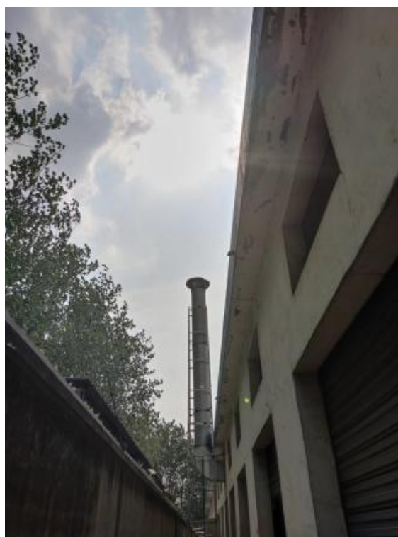
DA002 废气排放口
