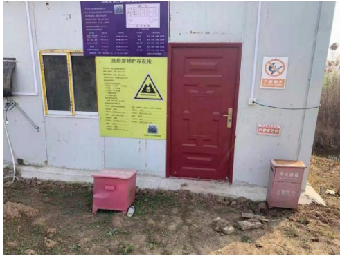
图 4.1-6 危废仓库现场建设情况
