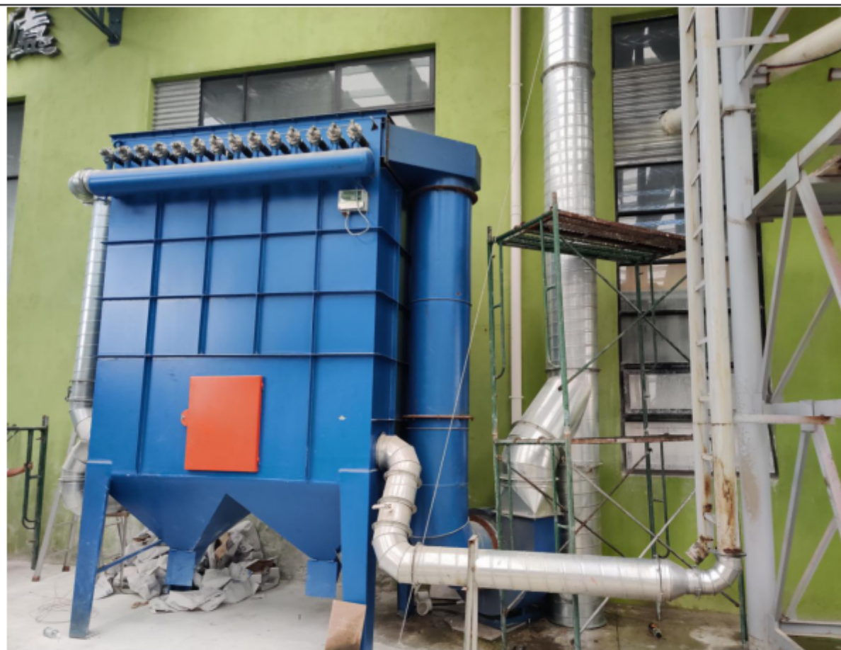
图 3-6 脉冲式布袋除尘器
