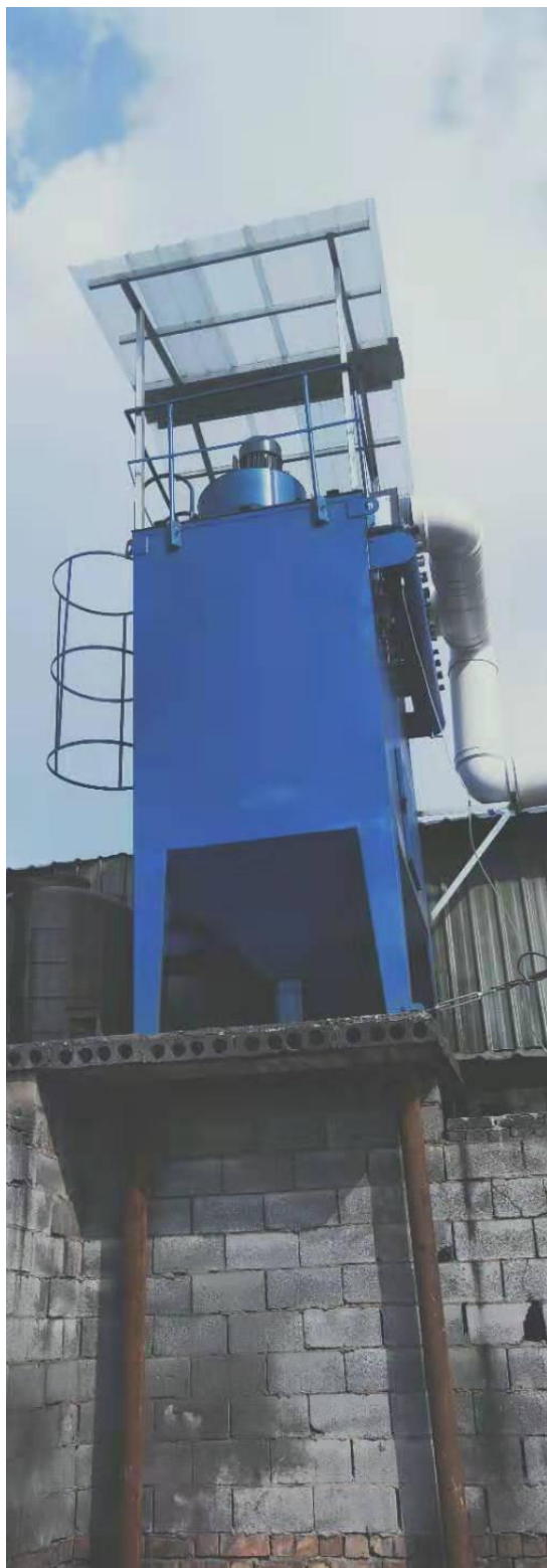
图 3-4 电熔炉配套悬挂式除尘器
