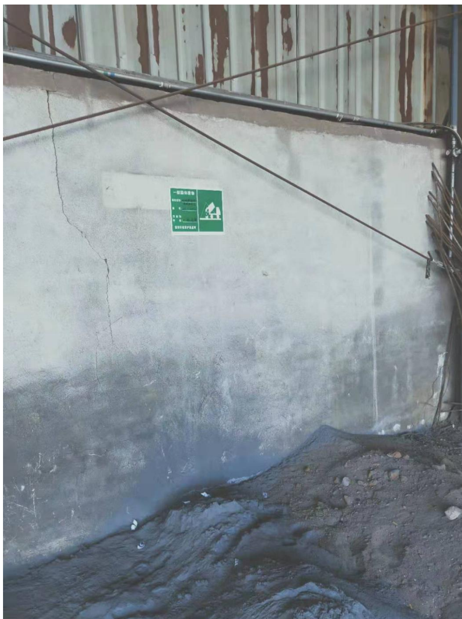
图 3-3 一般固废堆放处
