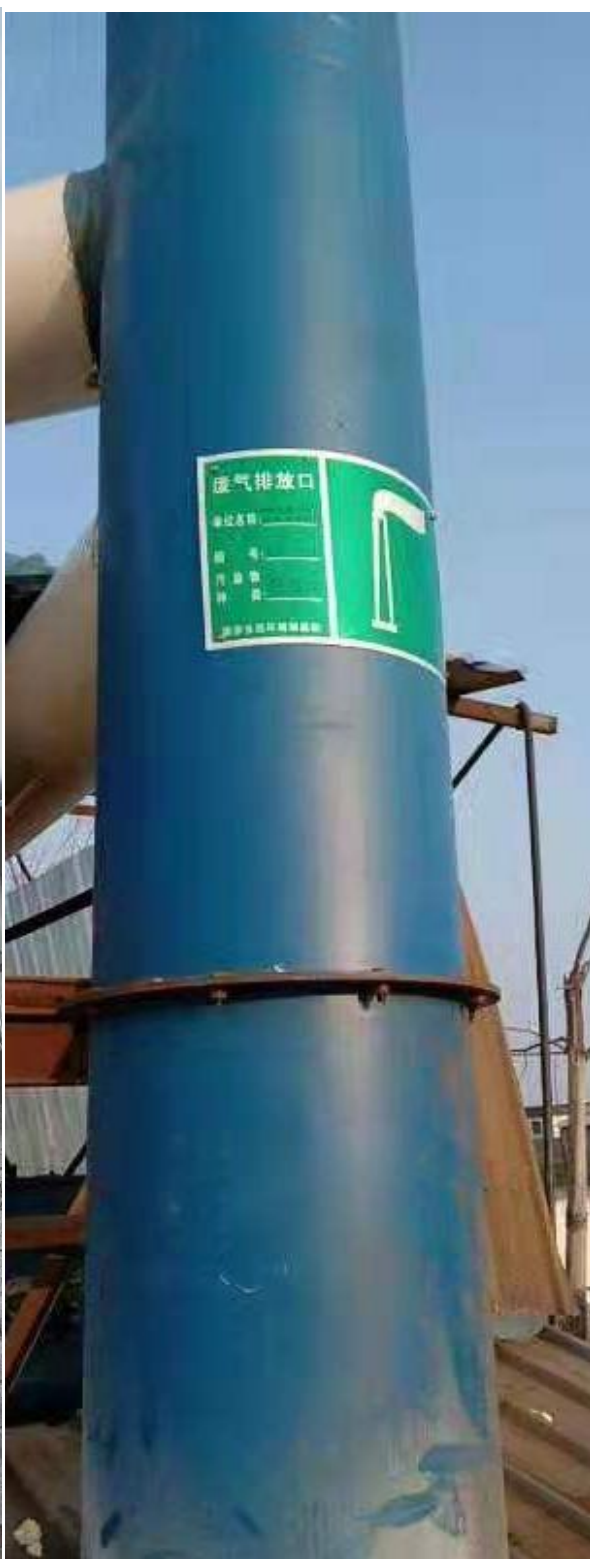
图 3-5 15 米高排气筒
